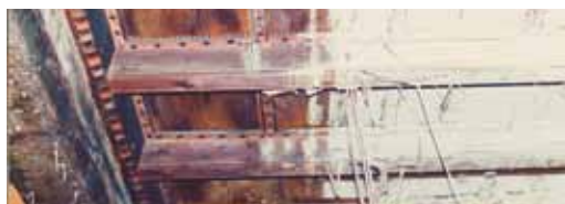
I soffitti decorati del '500 prima del restauro e del rinforzo strutturale
